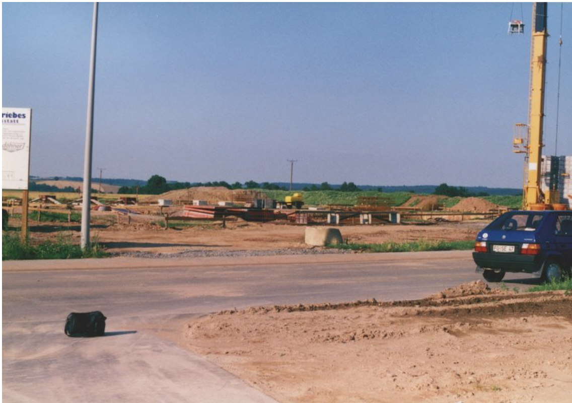
Abb. 18: Übersicht der Baustelle Aufschluss Nr. 3 (30.07.1995)
