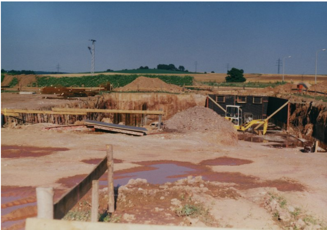
Abb. 19: Übersicht der Baugrube Aufschluss Nr. 3 (30.07.1995) mit Blick nach Osten auf die Schmohlhöhe 431,4 m HN, der höchsten Erhebung im Nordwestabschnitt des Niederbobritzscher Biotitgranites
