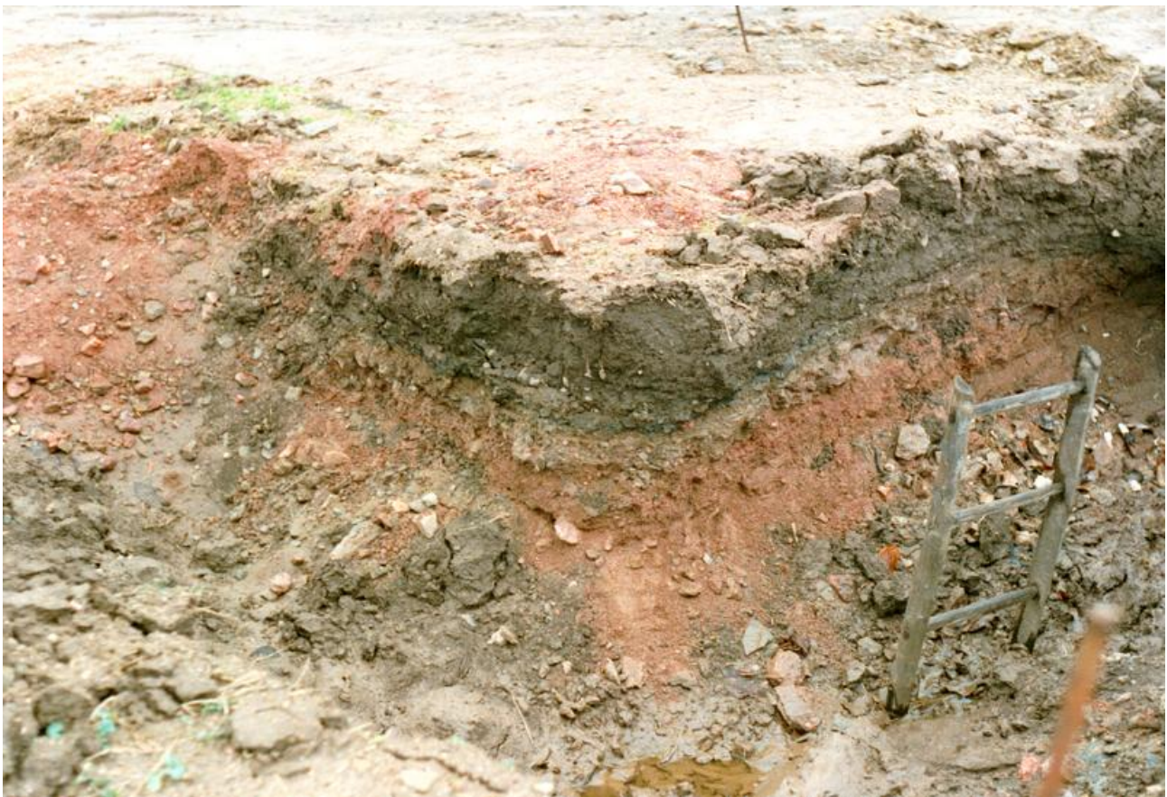
Abb. 23: Durch Tauwetter im Winter 1993/94 gebildete Schlamm und Geröll führende Schmelzwasserströme verschüttetes Schurfprofil frühpleistozän bis holozäner Hangschuttablagerungen am Mittelgutweg in 09627 Hilbersdorf
